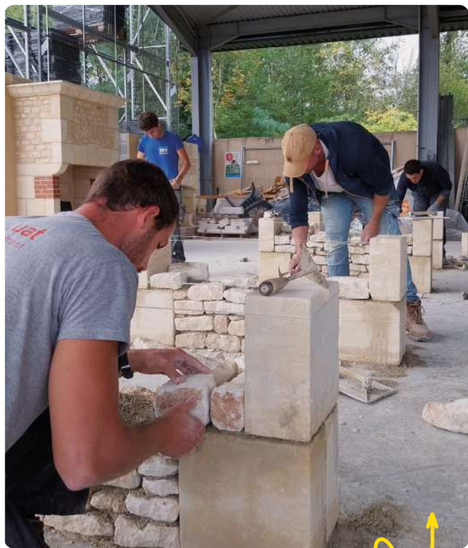
L'ATELIER MAÇONNERIE (SARLAT)
